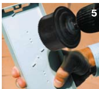
5 Отверстия для монтажных коробок прорезаются перед монтажом. Отметки с внутренней стороны монтажной платы позволяют точно установить фрезу в нужное положение.
