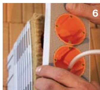
5 Отверстия для монтажных коробок прорезаются перед монтажом. Отметки с внутренней стороны монтажной платы позволяют точно установить фрезу в нужное положение.
