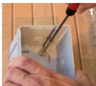
1 Прикрутите базу корпуса к стене.
